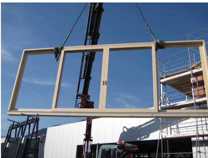
Hebeschiebetüre wird am Kran angehängt
